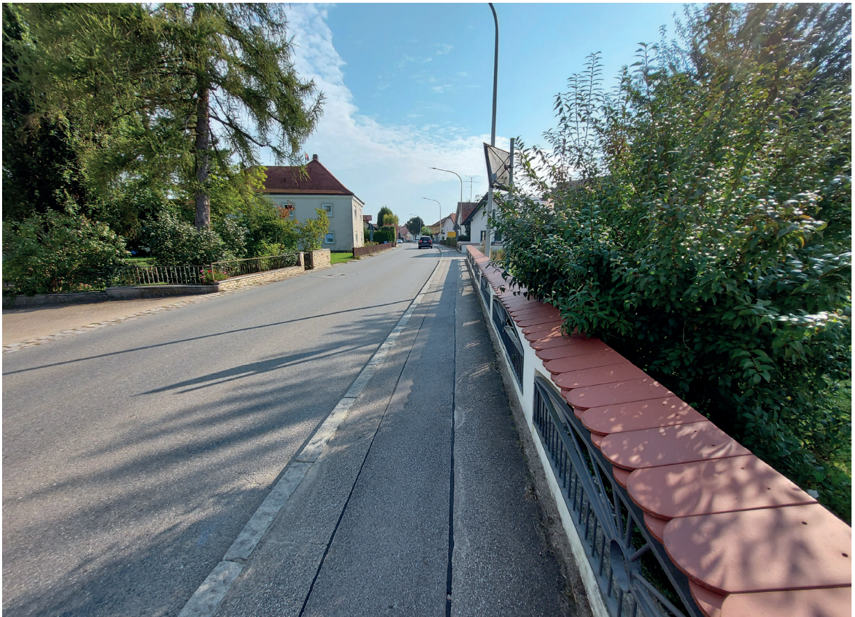
Straubinger Straße / Landshuter Straße schmale Gehwegsituationen
